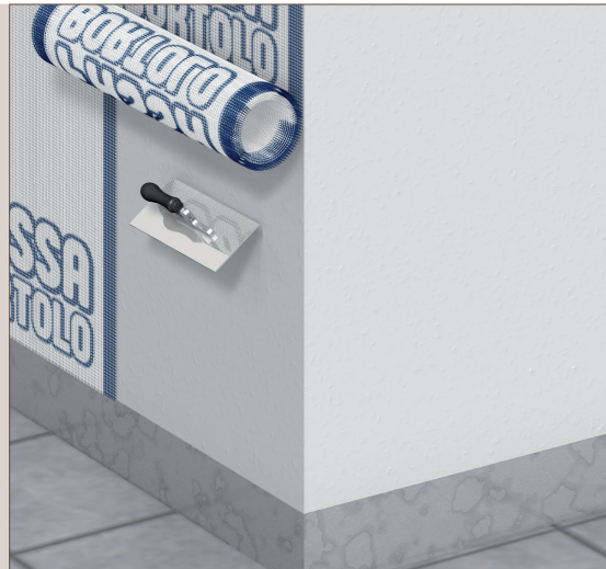
rasatura e posa rete di armatura Fassanet 160
