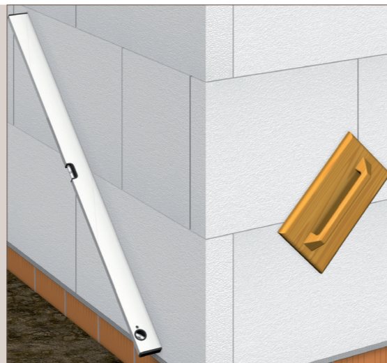
controllo della planarità della superficie
